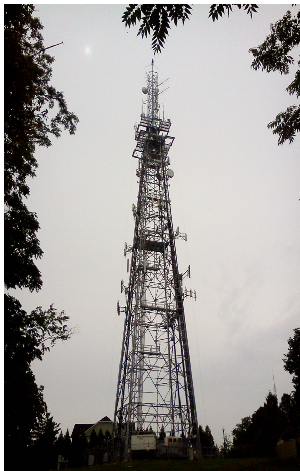
Abbildung 1: Ein Mobilfunkmast in einem Wohngebiet in den USA. Die große Anzahl verschiedener Antennen führt zu einem sehr starken elektromagnetischen Feld in den Schlafzimmern der Häuser im Umfeld des Funkmasts.
