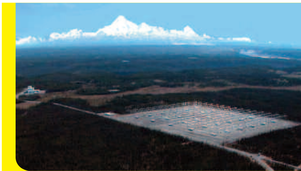
Fig. 25: Localización y construcción de HAARP
